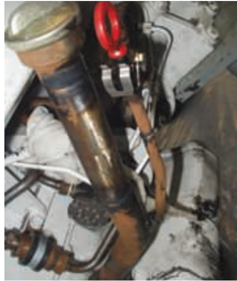
Şekil 1 Yağ seviye ölçüm borusundan yağ sızıntısı
