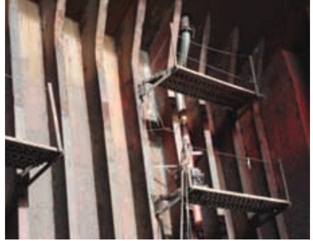
Şekil 3.6 Tank Perdesi Tamir Çalışması Posta Eklenmesi
