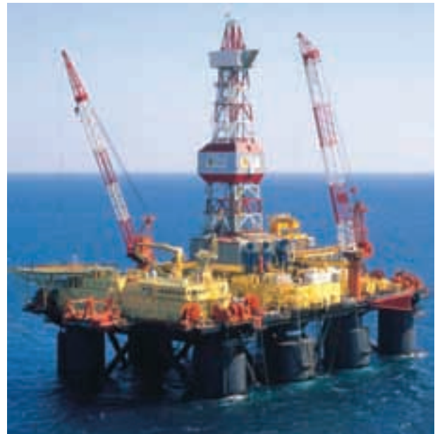
Şekil 4. SAİPEM firmasına ait Scarabeo7 açık deniz petrol platformu
