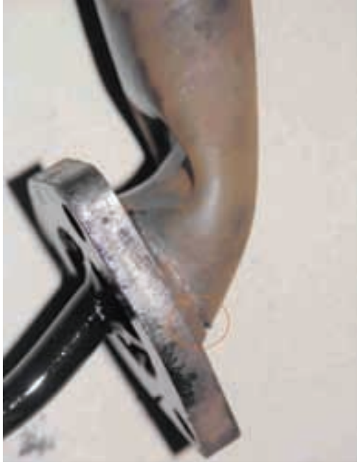
Şekil 2 Yağ seviye ölçüm borusu alt boynunda oluşan çatlak
